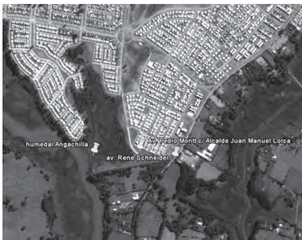
La Villa Claro de Luna. Serie de edificaciones que se encuentran entre las calles Av. Rene Schneider y Av. Pedro Montt, frente a ella se ubica el Centro Educativo San Nicolás.
