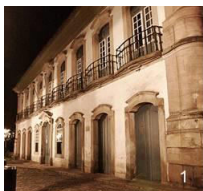
Foto 1: Fachada de la Casa dos Contos de la antigua Provincia de Vila Rica, actual ciudad de Ouro Preto, (MG) 1 . Fuente: José Eduardo Carvalho Monte.
