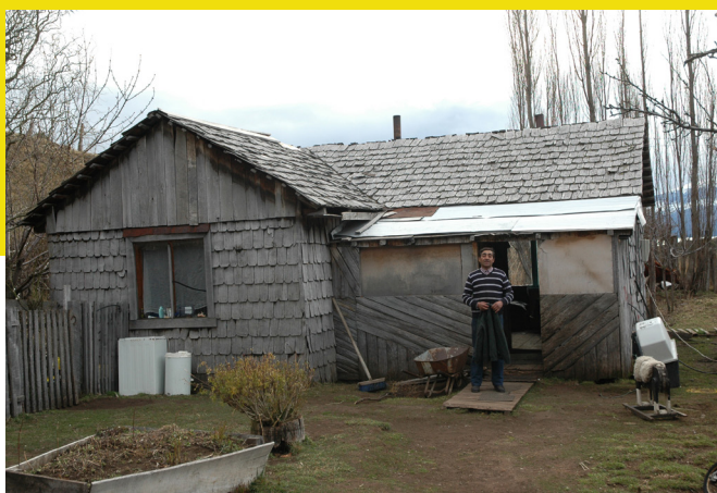
Figura 1. Poblador Pedro San Martín en su casa habitación en sector de Puerto Guadal, comuna de Chile Chico. Don Pedro apoyó estrechamente al equipo con la información de los pobladores y sectores en los cuales es posible encontrar construcciones en adobe y quincha desde principios de la década de 1920 en adelante. Fotografía: Carlos Castillo Levicoy, 2021
